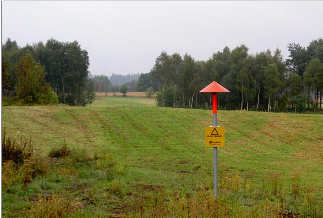
Figur 5. Markering av ledningssträckning.
