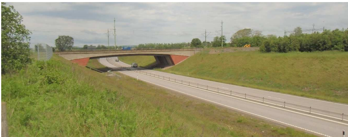
Figur 3. Fotot visar väg 154 och det område där borningen planeras under vägen. Fotot är taget norrut och vägens djup under järnvägsbron framgår av de branta slänterna.
