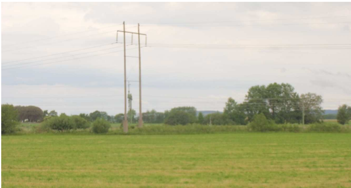
Figur 5. Av fotot framgår den flacka slättbygden som brer ut sig norr om området för markkabel-förläggningen. Ledningsstolpen i bilden är startpunkten för kabligen. Bakom skymtar järnvägen.
